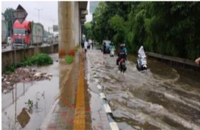
Banjir akibat pembangunan pilar yang menghambat aliran air
