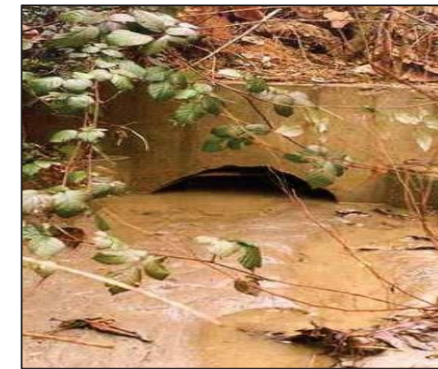
Gambar 2. Aliran Air Mengandung Sedimen
