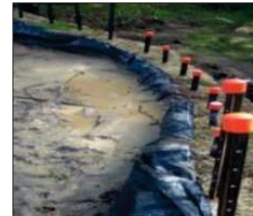
Gambar 3. Sedimen dari aliran air yang telah dikendalikan dengan pagar sedimen
