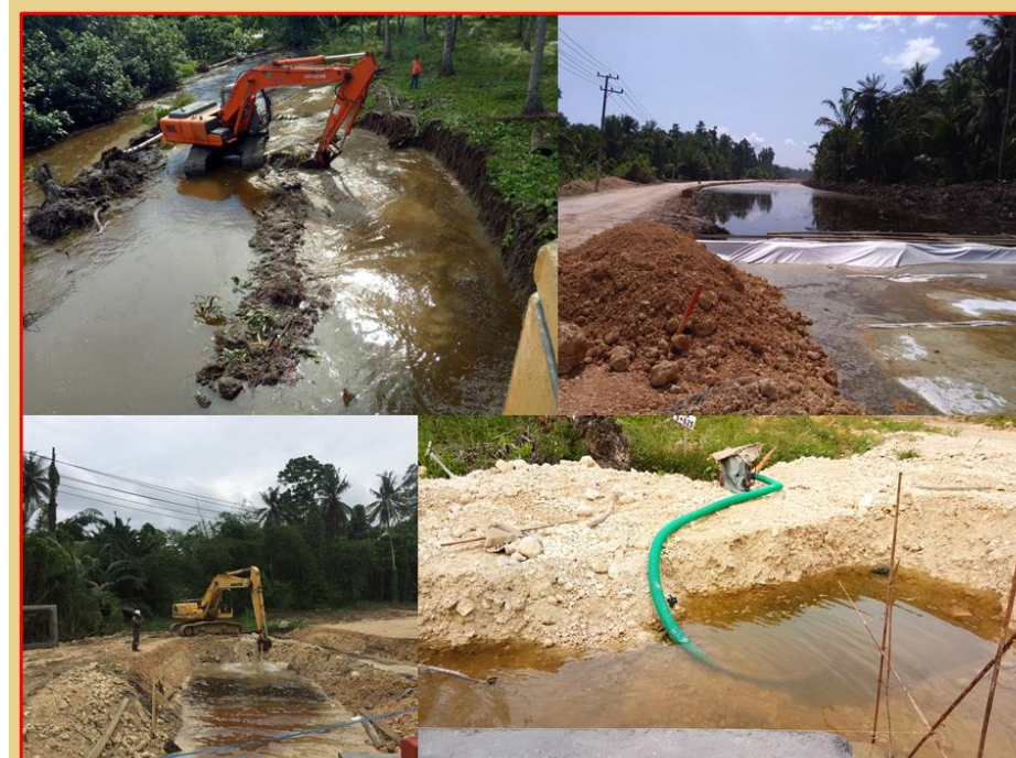
Gambar 3. Sedimen dari aliran air yang telah dikendalikan dengan pagar sedimen
