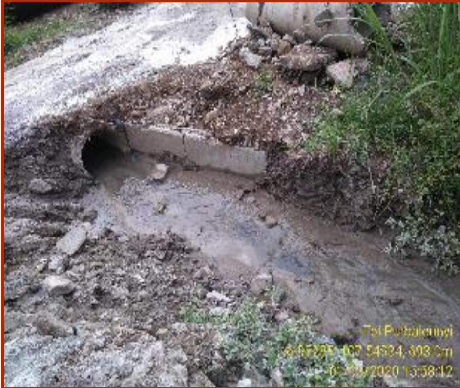
Kondisi saluran air yang digunakan untuk mencuci truck mixer
