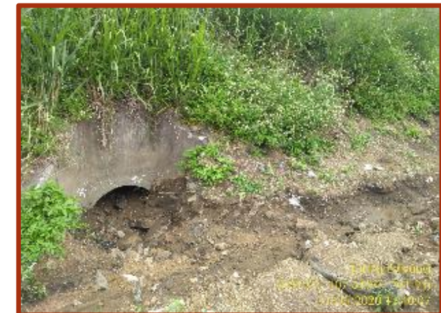
Sedimentasi dan penumpukan sampah pada saluran air dan cross drain
