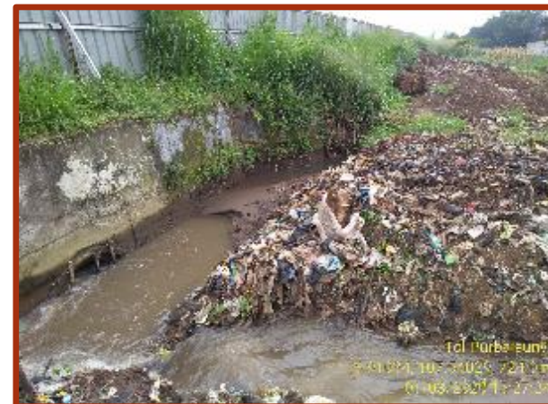
Sedimentasi dan penumpukan sampah pada saluran air dan cross drain
